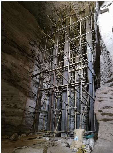
图 6 框架式钢结构临时支护
